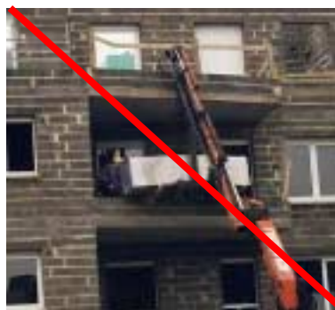
Recette improvisée Déchargement à la volée
