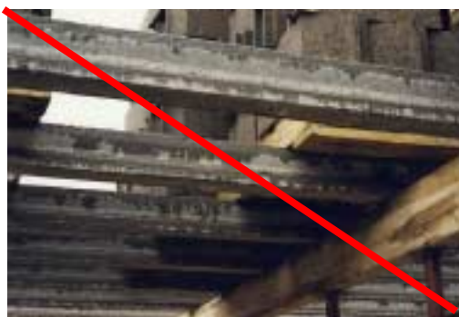
Charges ponctuelles sur poutrelles Effondrement, instabilité
