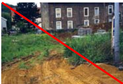
Accès non stabilisé
