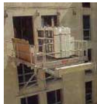
Installation d'une recette à matériaux
