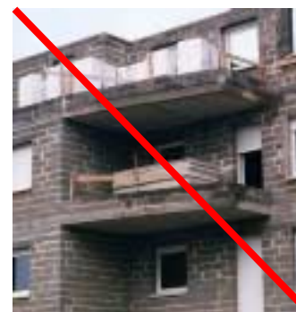
Recette improvisée Surcharge des balcons
